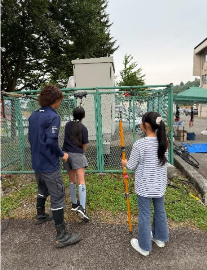
間接活線工法による カバー取付体験
